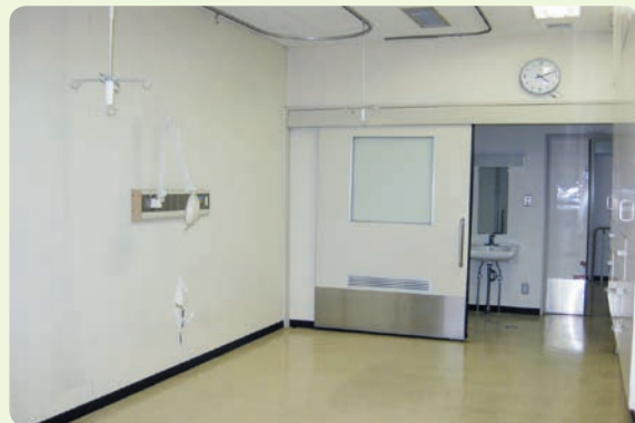
【改修前】2病棟 居室
